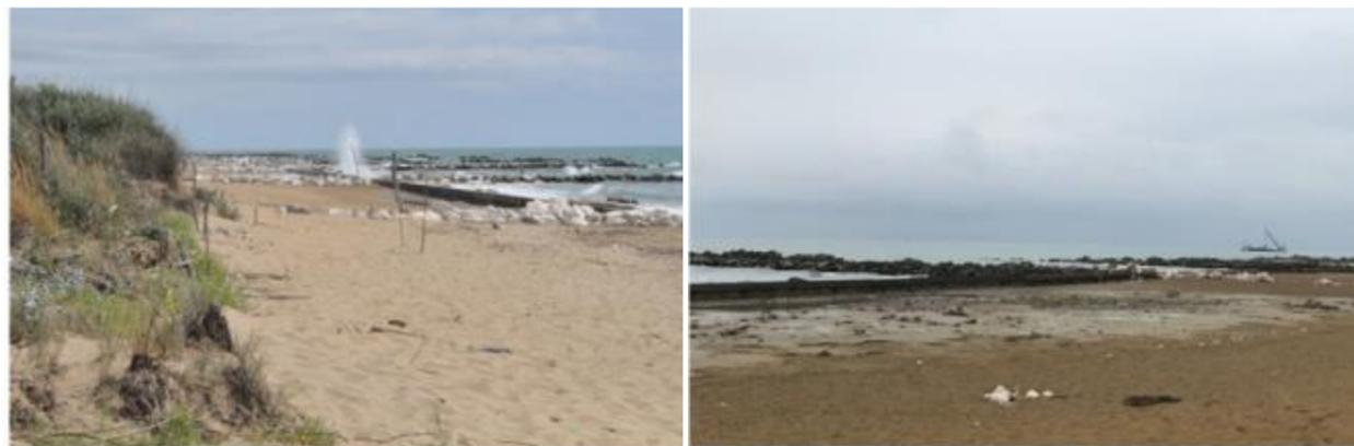
Figura 2 5: Spiaggia della Laguna del Mort, a sud ovest dell’area d’intervento; si nota il diaframma in calcestruzzo, emergente rispetto alla spiaggia, e i pennelli in pietrame
