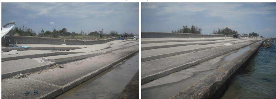
Figura 2 4: Danni strutturali alla gradonata
